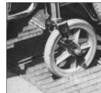
A1-6 Griglia non conforme alla normativa e posizionata con orientamento errato
