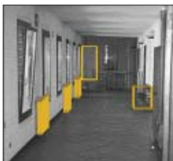
A1-29,30 Arredo lungo il percorso: in questo caso non costituiscono strozzature rilevanti, ma si ritiene opportuno il loro alloggiamento in nicchia
