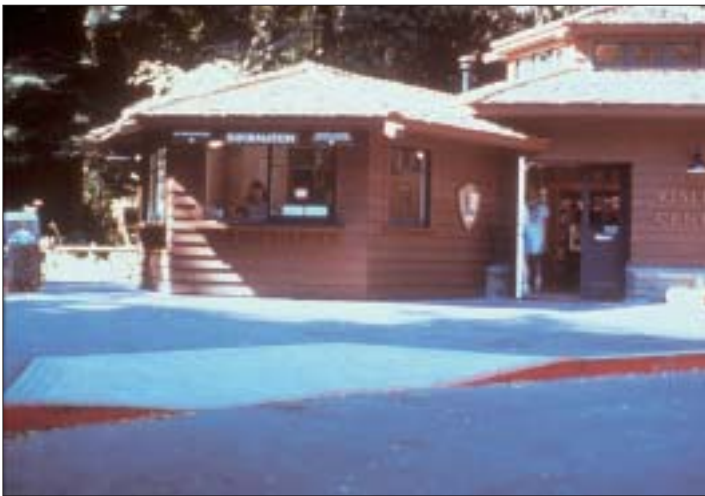
Foto n. 53 – Muir Wood National Park, California, Stati Uniti: una rampa di raccordo collega i parcheggi riservati con il centro visite.
