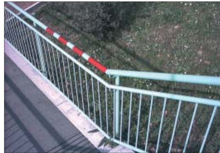
Foto n. 17 - Curvatura verticale con buon contrasto cromatico e tattile, infatti in corrispondenza delle fasce colorate il corrimano è più ruvido.
