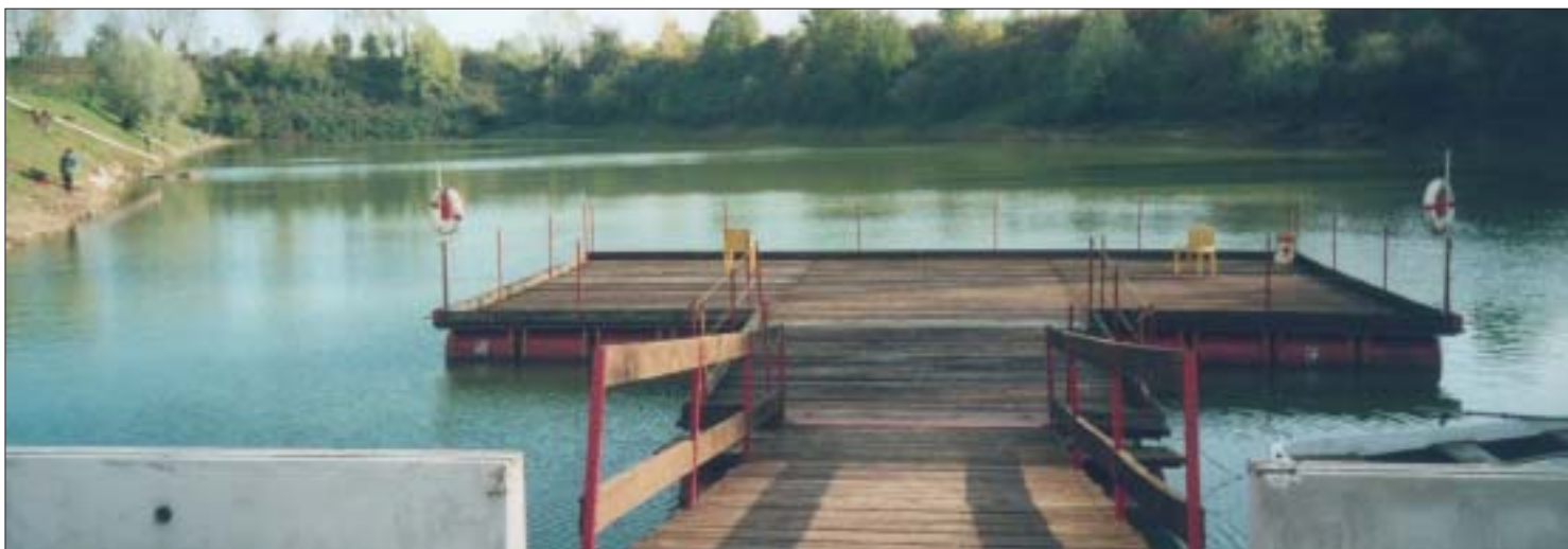
Foto n. 51 - Pontile per la pesca (in via di completamento). Laghetto Fips di Montecchio Precalcino (Vi).
