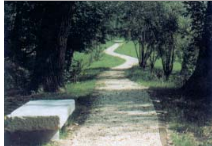
Foto n. 38 - Fontana di Venchieredo, Sesto al Reghena, Pordenone: veduta di un percorso con pavimentazione in pietrisco compattato e cordoli laterali in legno, riconoscibili dai non vedenti mediante percussione con il bastone (progetto arch. P. De Rocco).
