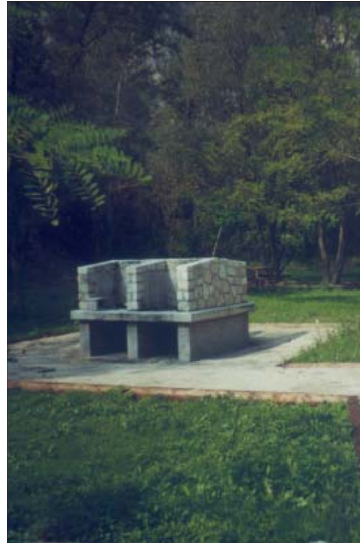
Foto n. 49 - Bosco delle Fontane a Cison del Grappa (VI): area con piani cottura collegata alle aree picnic.
