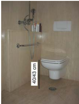
Tazza del servizio igienico posizionato ad un'altezza di 40-43 cm
