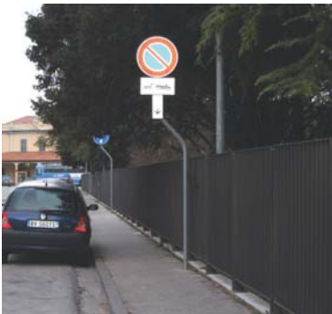
Posizionamento e sagomatura corretta del palo della segnaletica stradale
