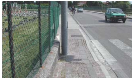
Palo sul marciapiede in corrispondenza di un attraversamento pedonale
