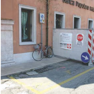
Parceggio riservato su fondo sconsesso e lavori in corso che limitano lo spazio
