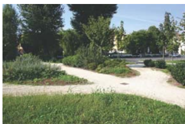
Fondo pavimentazione in misto ghiaino
