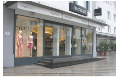
Abbinamento corretto tra rampa e scalini; è mancante un idoneo corrimano
