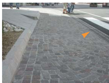
Abbinamento corretto tra marciapiede e attraversamento pedonale
