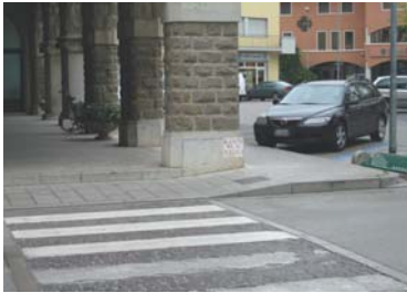
Passaggio pedonale rialzato
