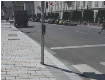
Esempio di pavimentazione dotata di superfici tattili
