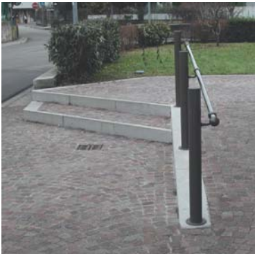
Gradini e rampa per l'accesso
