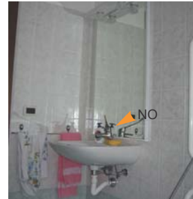
Lavabo standard con rubinetto di tipo chirurgico
