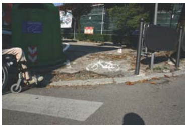
Marciapiede sconnesso in corrispondenza di un attraversamento stradale
