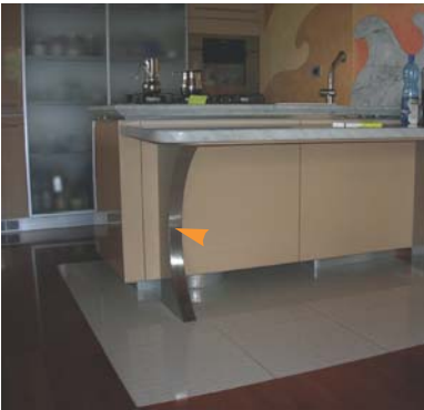
Tavolo da cucina con montanti verticali curvi per consentire una libera rotazione della sedia a ruote e quindi una più facile accessibilità al piano di lavoro
