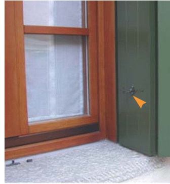
Anello per agevolare la chiusura: scuro
