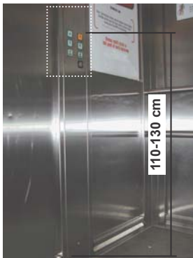
Altezza minima e massima della pulsantiera da terra
