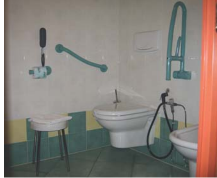
Corretta collocazione della tazza wc e degli ausili (maniglioni, doccetta, campanello di chiamata-citofono)
