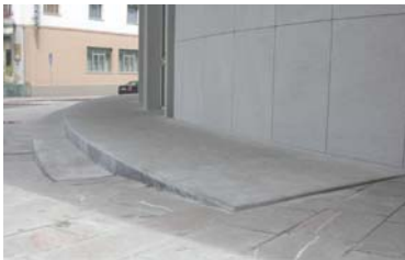
Rampa priva di raccordo con spigoli smussati
