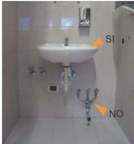
Lavabo standard con rubinetto comandato a pedale
