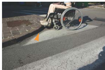
Particolare gradino in corrispondenza di un attraversamento pedonale
