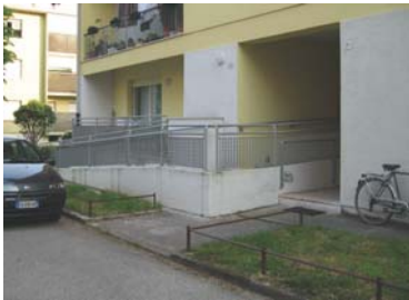
Rampa accesso residenza
