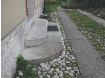
Pavimentazione in acciottolato e lastre di pietra a spacco
