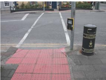
Attraversamento pedonale e superficie tattile
