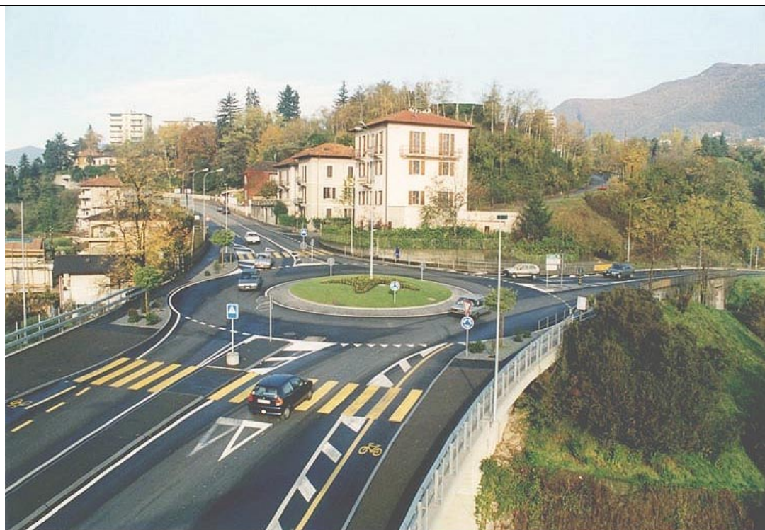
4. Balerna, Canton Ticino. Rotatoria di 31 m di diametro esterno. La pista ciclabile arriva in rotatoria fino all'anello, quindi le biciclette proseguono circolando come veicoli sulla carreggiata anulare. Questa soluzione è diversa da quella praticata sulle rotatorie americane in cui pedoni e ciclisti sull'intersezione condividono un percorso protetto sul marciapiede, e attraversano la rotatoria sui rami. (Foto: Dipartimento Territorio Cantone Ticino (Ti-CH)).
