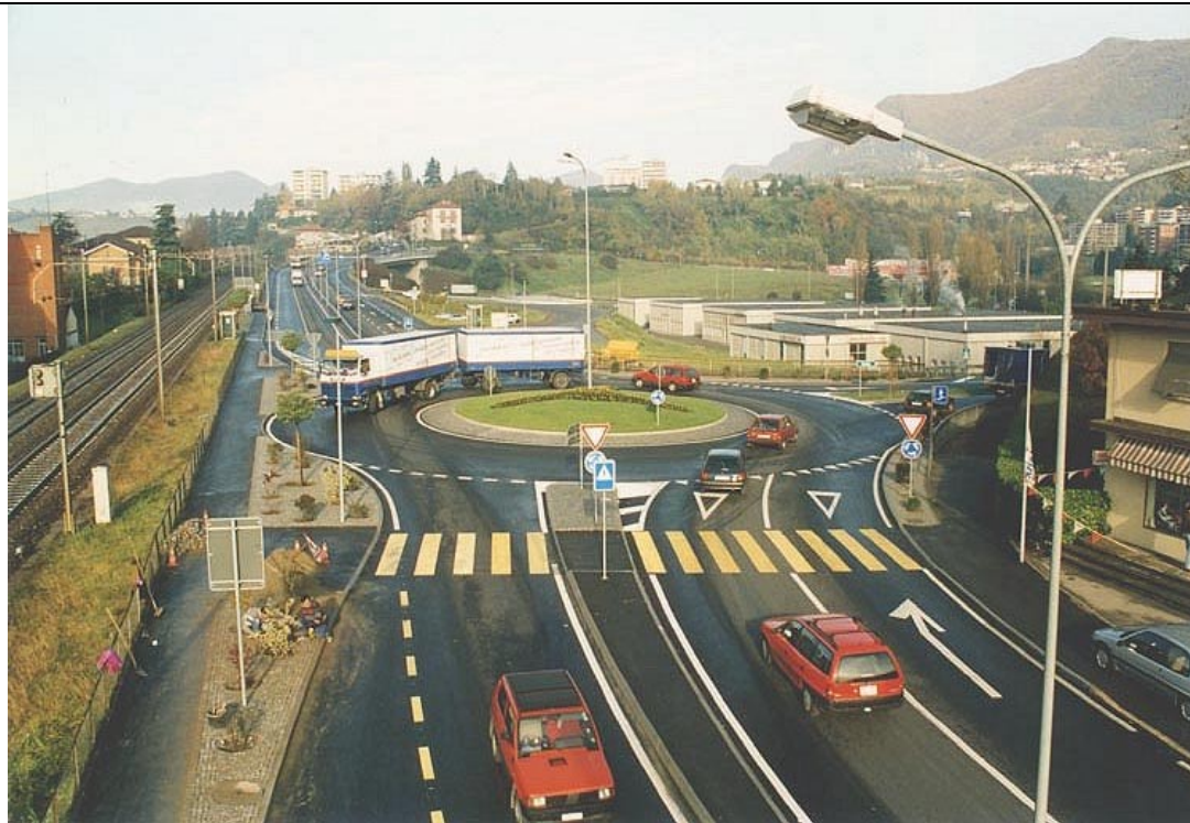
3. Balerna, Canton Ticino. Rotatoria di 32 m di diametro esterno. Si nota la deflessione di immissione in rotatoria per impedire il transito con veloce con traiettoria tangente all'isola di rotazione.
